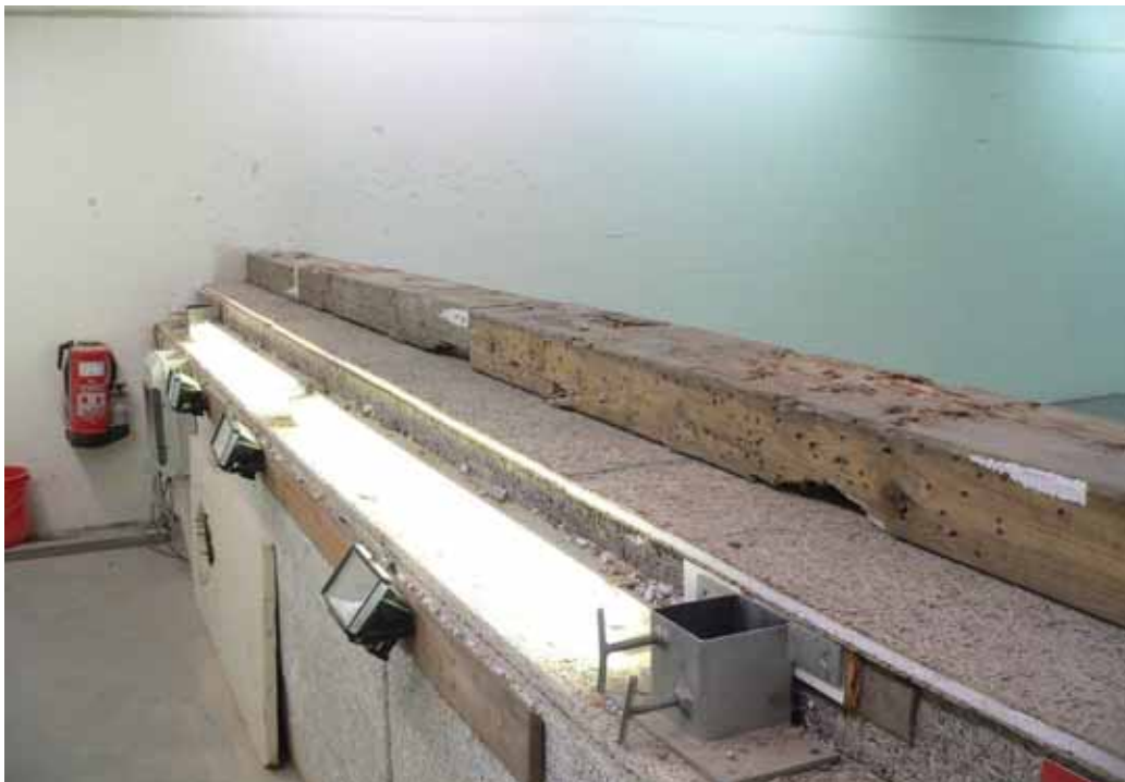
auch die mittlere Brüstung wurde wieder erneuert...
