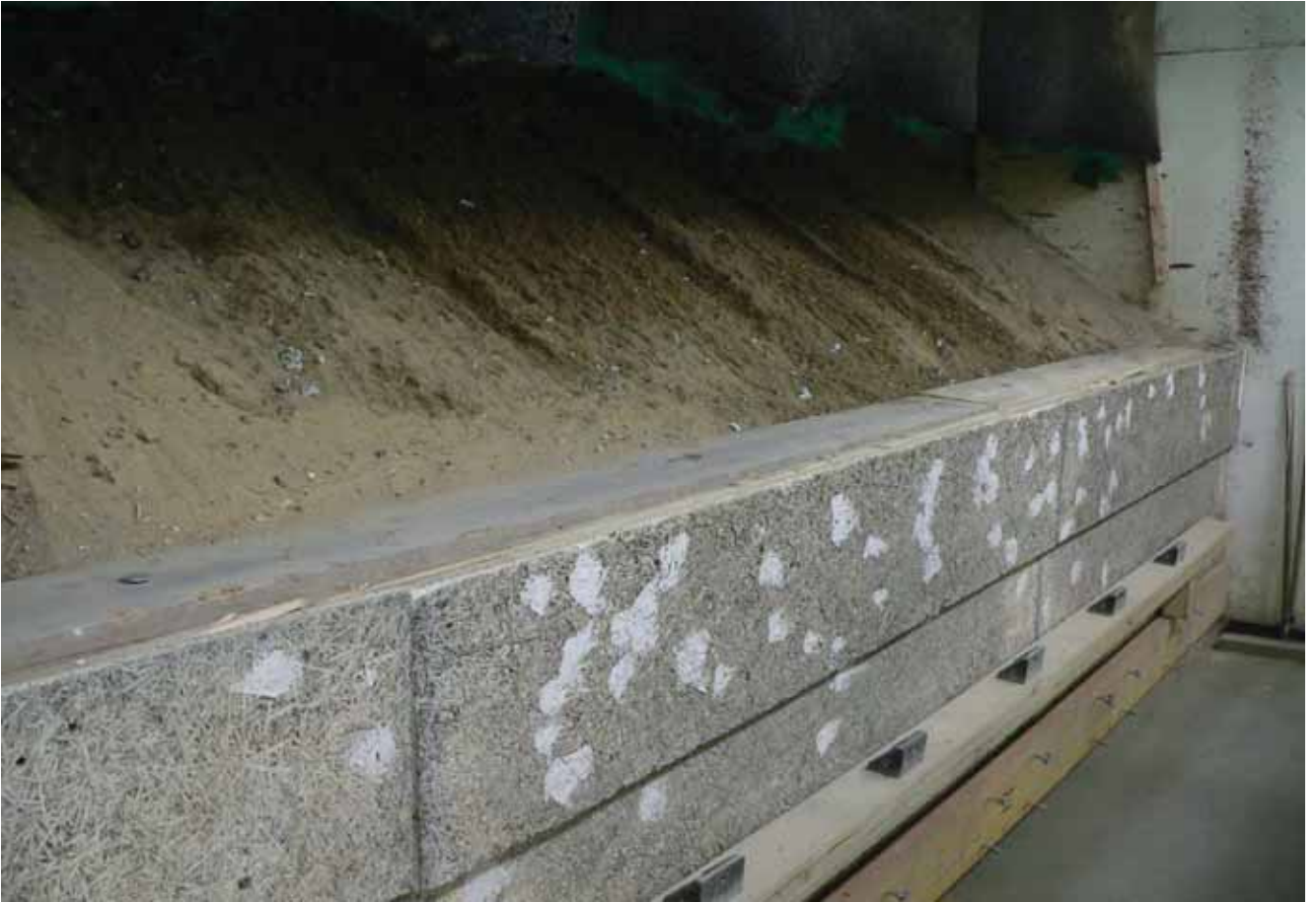
die obere Abdeckung der hinteren Brüstung wurde stabil erneuert
