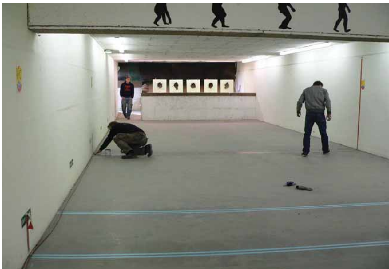
nach dem Testen haben wir noch mal eben die Bodenmarkierungen aufgebracht.
