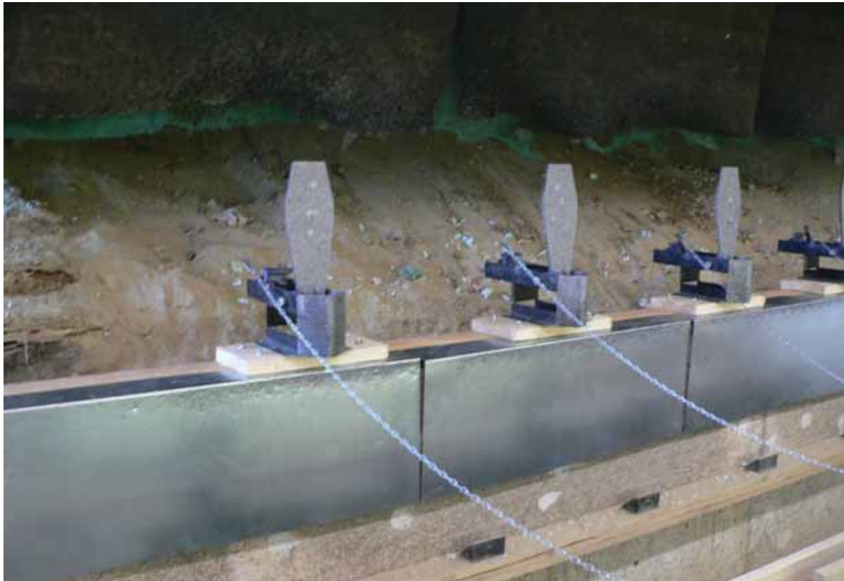
neue verbesserte Halterungen sollen die Auf und Abbauzeiten verringern
